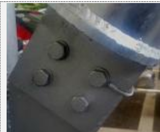
공단에 설치된 태양광 (용융아연도금된 구조물)
